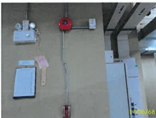
อุปกรณ์แจ้งเหตุ พร้อมไฟส่องสว่างฉุกเฉิน
