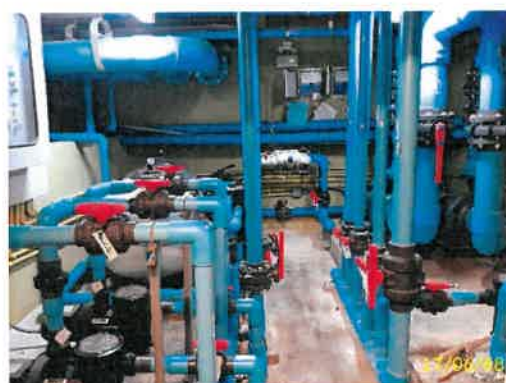
เครื่องกรองสระว่ายน้ำอาคาร B
