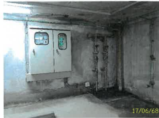
เครื่องสูบน้ำ และตู้ควบคุมการระบายน้ำชั้นใต้ดินอาคาร B
