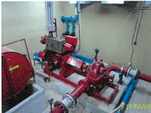
ปั้มน้ำเพื่อการดับเพลิงชั้นใต้ดิน อาคาร A
