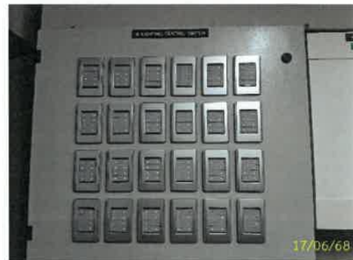
ตัวควบคุมระดับแสงสว่างอาคาร A
