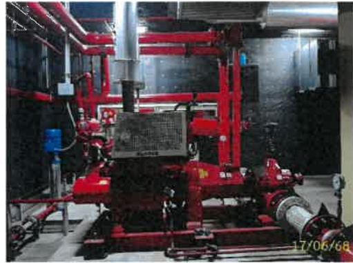
ปั๊มน้ำเพื่อการดับเพลิงชั้น 28M อาคาร A
