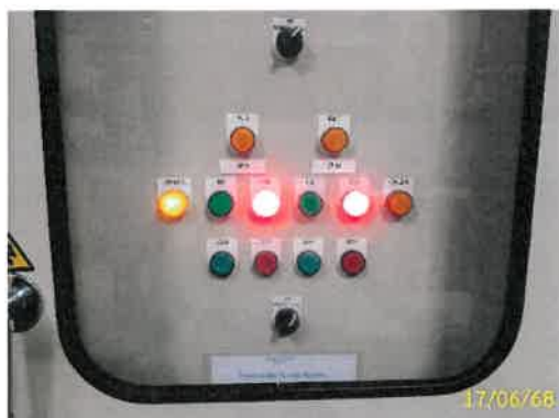
ตู้ควบคุมการระบายน้ำขึ้นใต้ดินตัวที่ 1 อาคาร A
