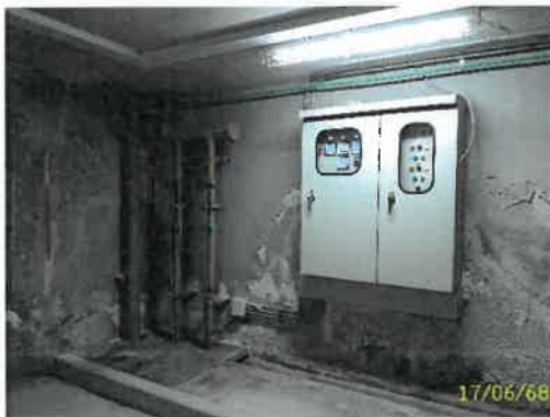
เครื่องสูบน้ำ และตู้ควบคุมการระบายน้ำชั้นใต้ดินอาคาร B
