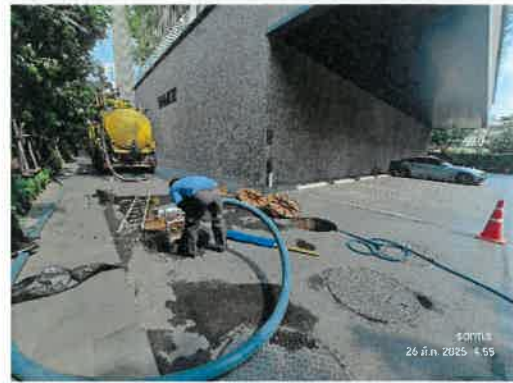
สูบล้างระบบบำบัดอาคาร B
