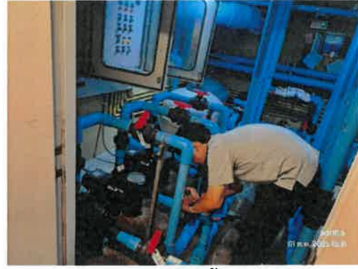
ล้างกรองสรว่ายน้ำอาคาร B
