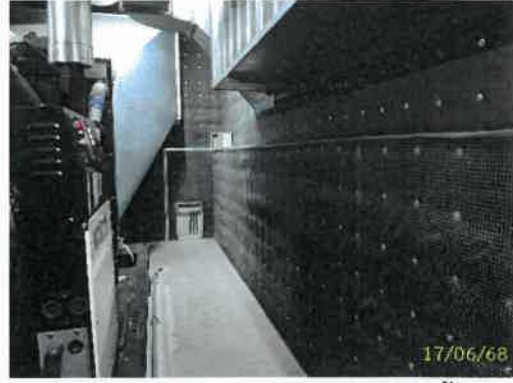
ช่องว่างระหว่างเครื่องกำเนิดไฟฟ้ากับผนังกันเสียง
