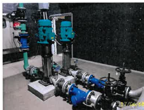
ปั๊มน้ำเพื่อการอุปโภค-บริโภค ชั้น 28M อาคาร A
