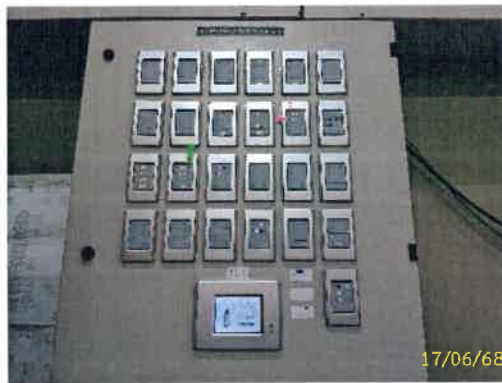
ตัวควบคุมระดับแสงสว่างอาคาร B
