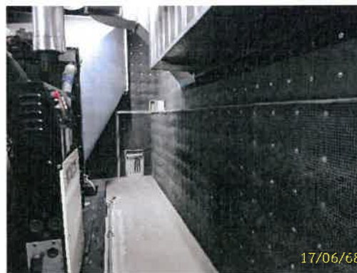
ช่องว่างระหว่างเครื่องกำเนิดไฟฟ้ากับผนังกันเสียง
