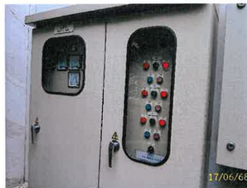
ดูควบคุมบ่อสุดท้ายก่อนปล่อยลงสาธารณะ
