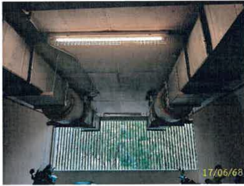
ภาพที่ 2.2-4 ระบายอากาศที่จอดรถ
