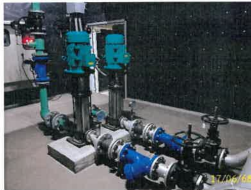
ปั้มน้ำเพื่อการอุปโภค-บริโภค ชั้น 28M อาคาร A
