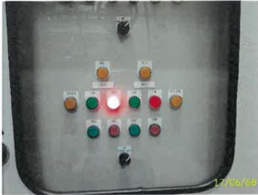
ตู้ควบคุมการระบายน้ำชั้นใต้ดินตัวที่ 2 อาคาร A
