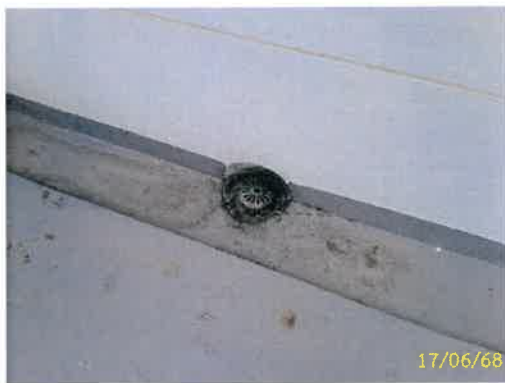
หัวรับน้ำฝนจากหลังคา
